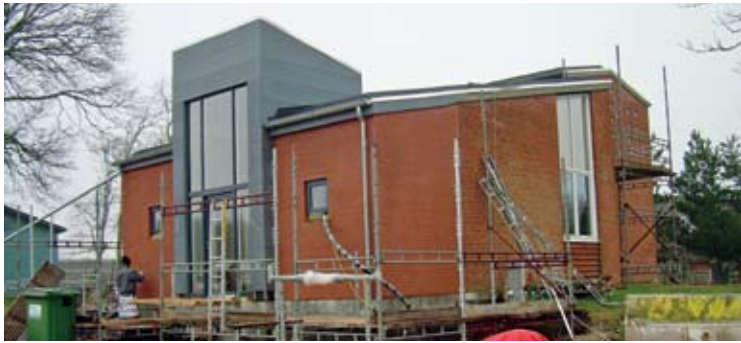
Renovering af Nordre Vandværk med opførelse af sluse, der fungerer som hygiejnebarriere.
